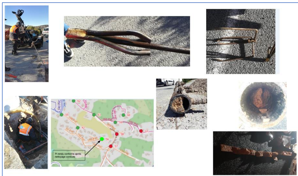
Figure 24 : Désincrustation d'une conduite d'eau potable rendue conforme sur le Domaine de Séguret aux Adrets de l'Estérel
