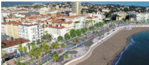
Une vue de la future Promenade des Bains après neuf mois de travaux.
